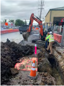
Digging trench for electrical conduit / Excavación de zanjas para conductos eléctricos
