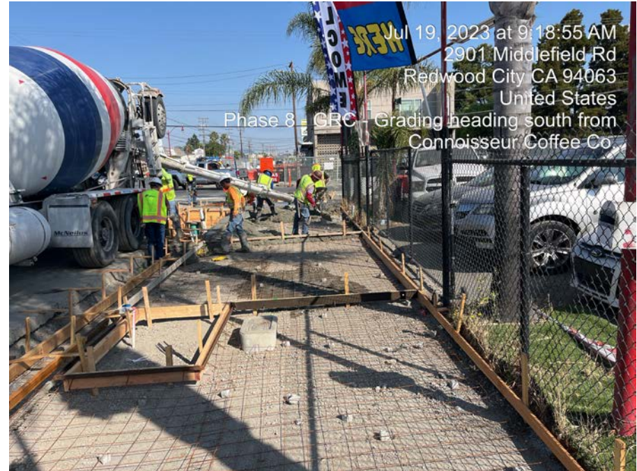
Phase 8 sidewalk pour
