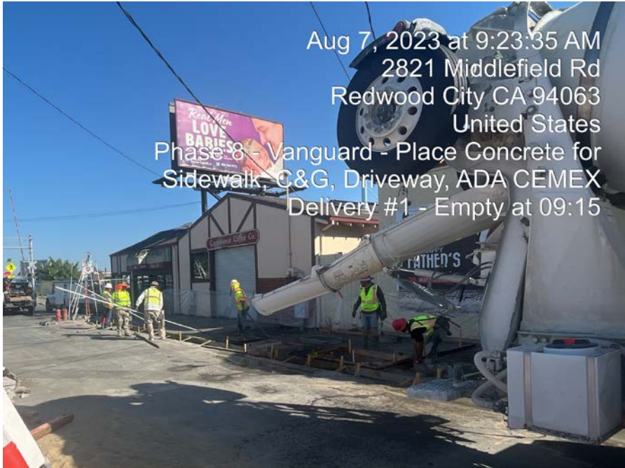
Phase 8 sidewalk pour
