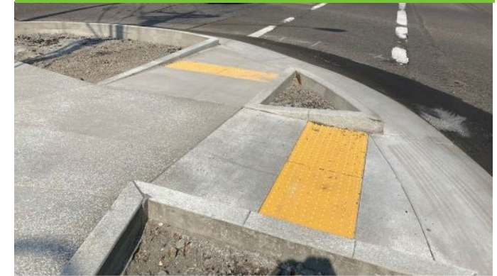
ADA Curb Ramps
